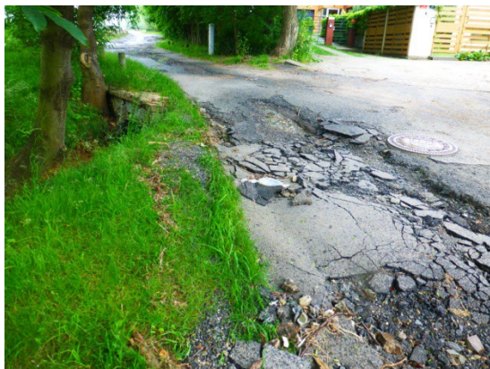
Foto: současný stav cesty
